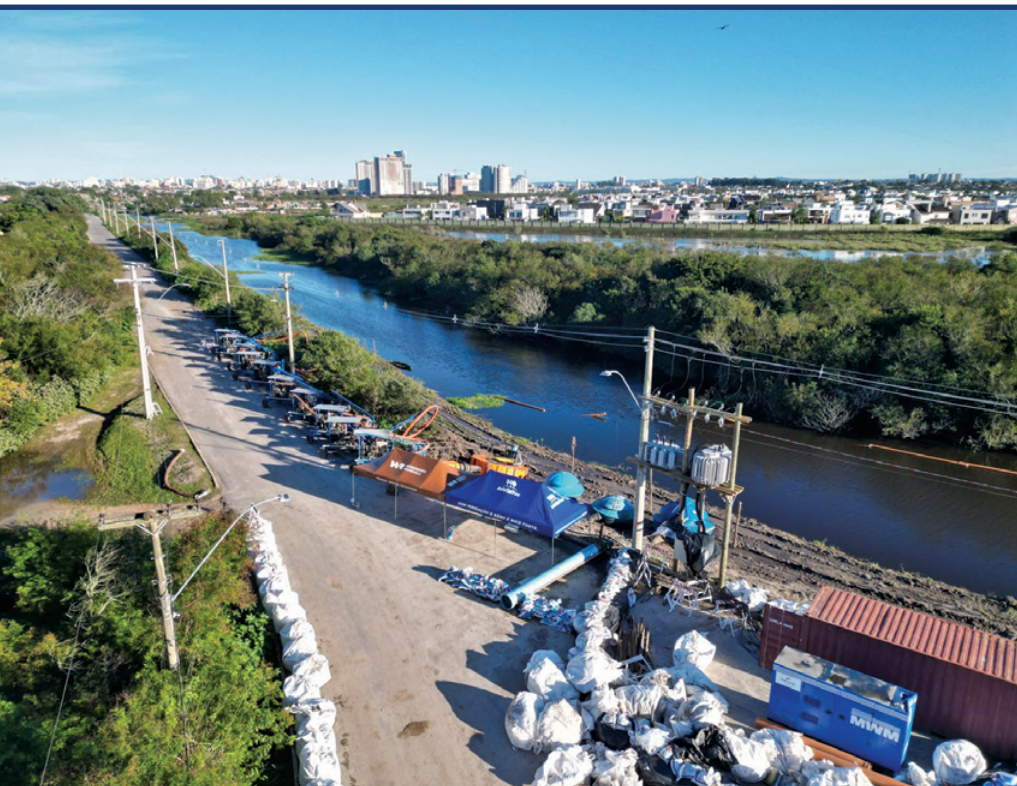
Quantidade de máquinas e equipamentos à beira do Canal São Gonçalo dá uma ideia da dimensão do Projeto Drenar
