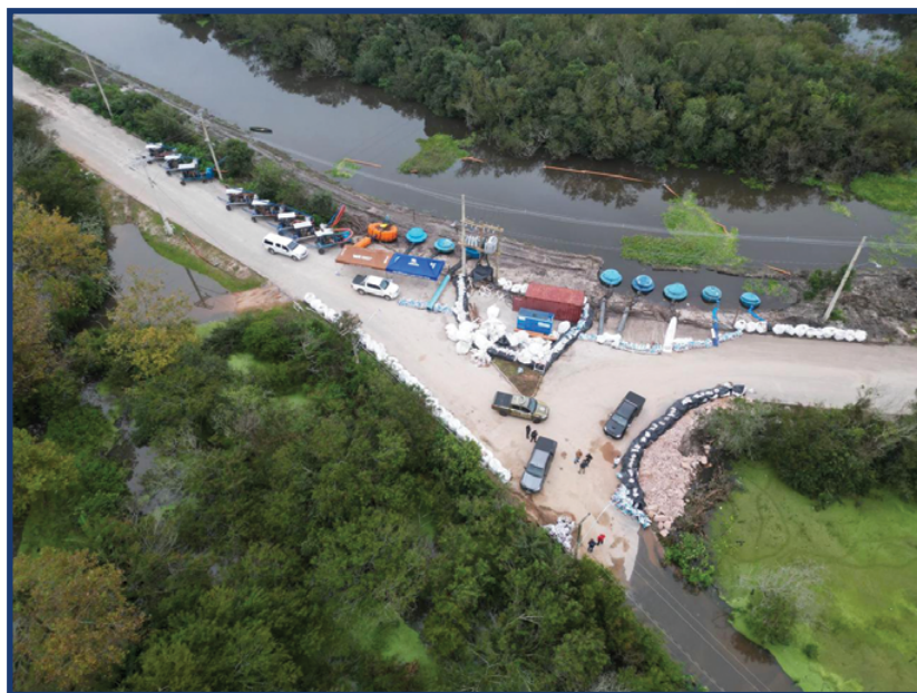
Sistema de drenagem montado na Estrada do Engenho, em Pelotas
