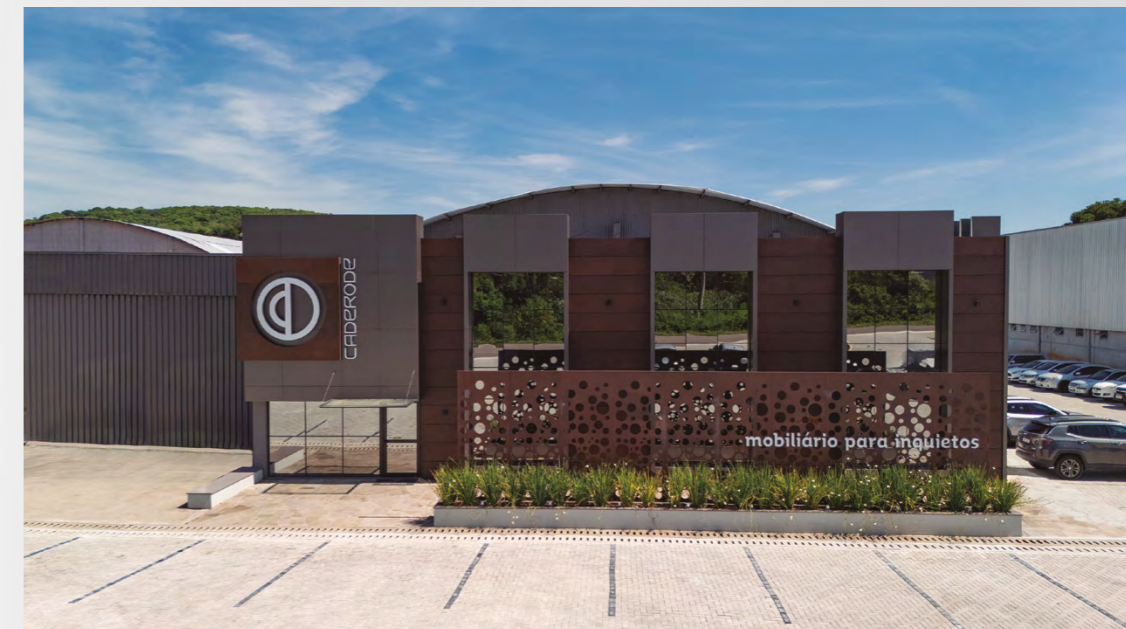
Fachada nova da empresa.
